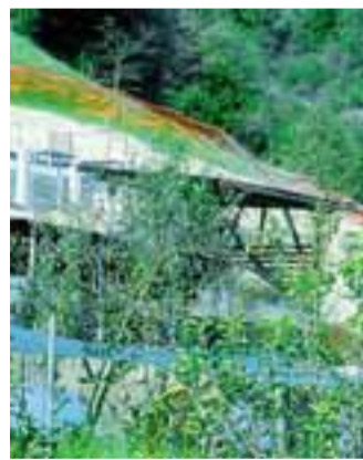
Il cantiere a Cornello dei Tasso
